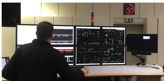
In der Netzleitstelle wurde gezeigt, wie bei Komplikationen Strom in der Leitstelle umgelenkt werden kann.
